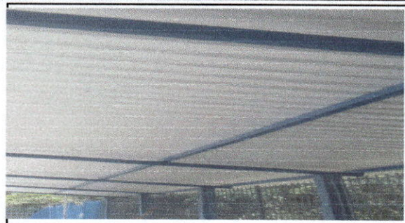
Foto 2: Mantenimiento a estructura de soporte de metal
